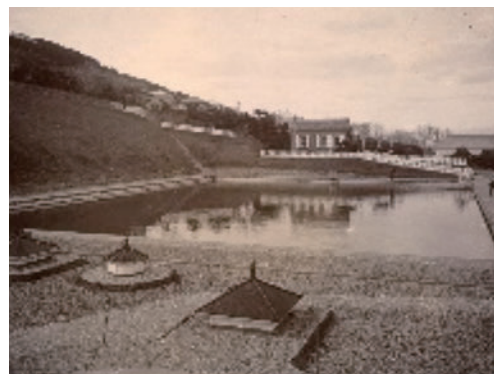
元町配水池(明治22年)
