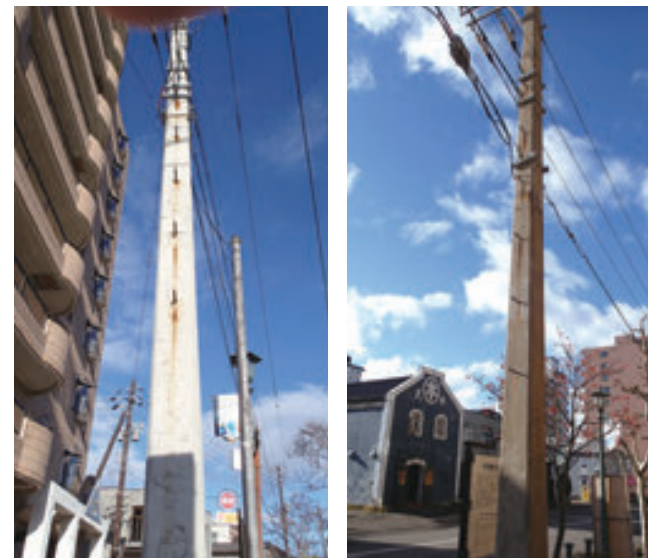
現存する日本最古のコンクリート電柱(函館市末広町)
