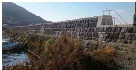
函館漁港船入澗防波堤
