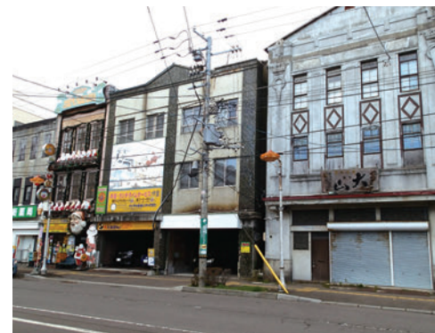
銀座通りには当時の外観を残す建物が現存する
