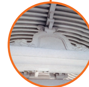
天井の梁までコンクリートで造られています!
