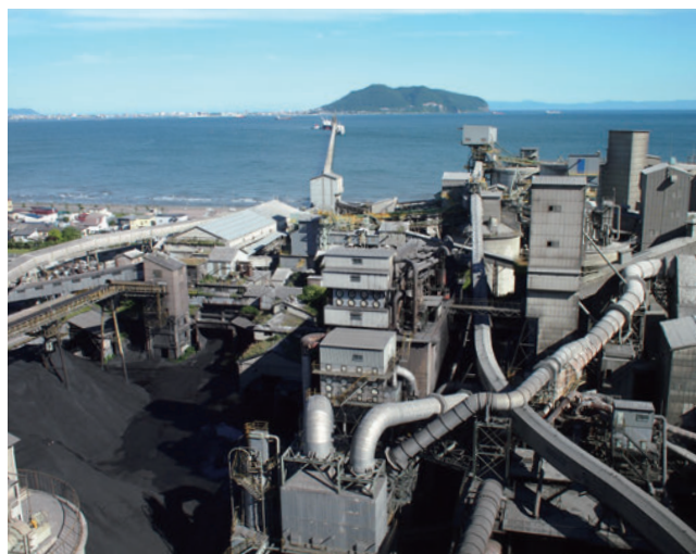
太平洋セメント 工場
