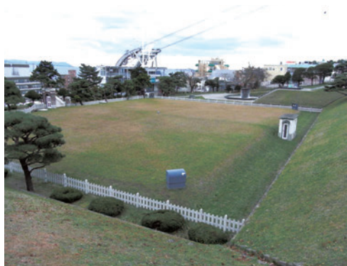
現在の元町配水池
