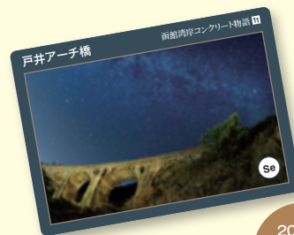
戸井アーチ橋
