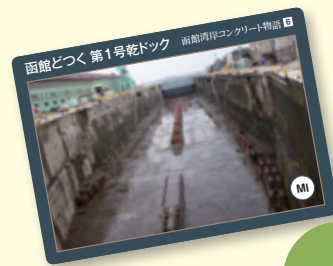
函館どつく 第1号乾ドック
